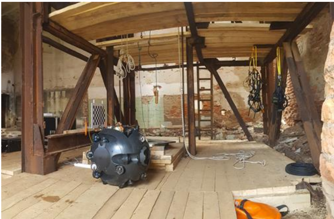
Рис. 43 Робот UX-1Neo на вході у вентиляційну шахту 9
