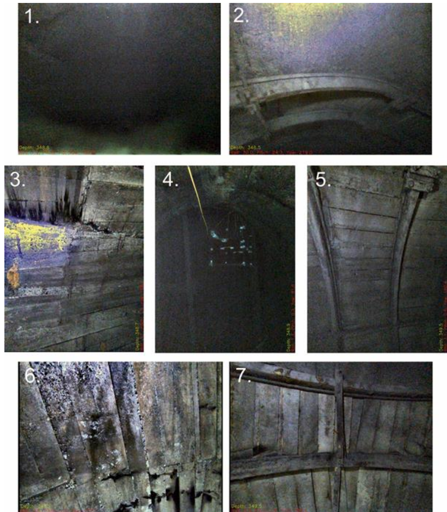
Рис. 47 Візуальне зображення бічного проходу на глибині 366 м: 1) вид входу з фронтальної камери; 2) вид бетонного входу з фронтальної камери; 3) вид бетонної частини входу, фото зроблене бічною камерою; 4) шахта та каркас, фото зроблене бічною камерою; 5) бічна камера
