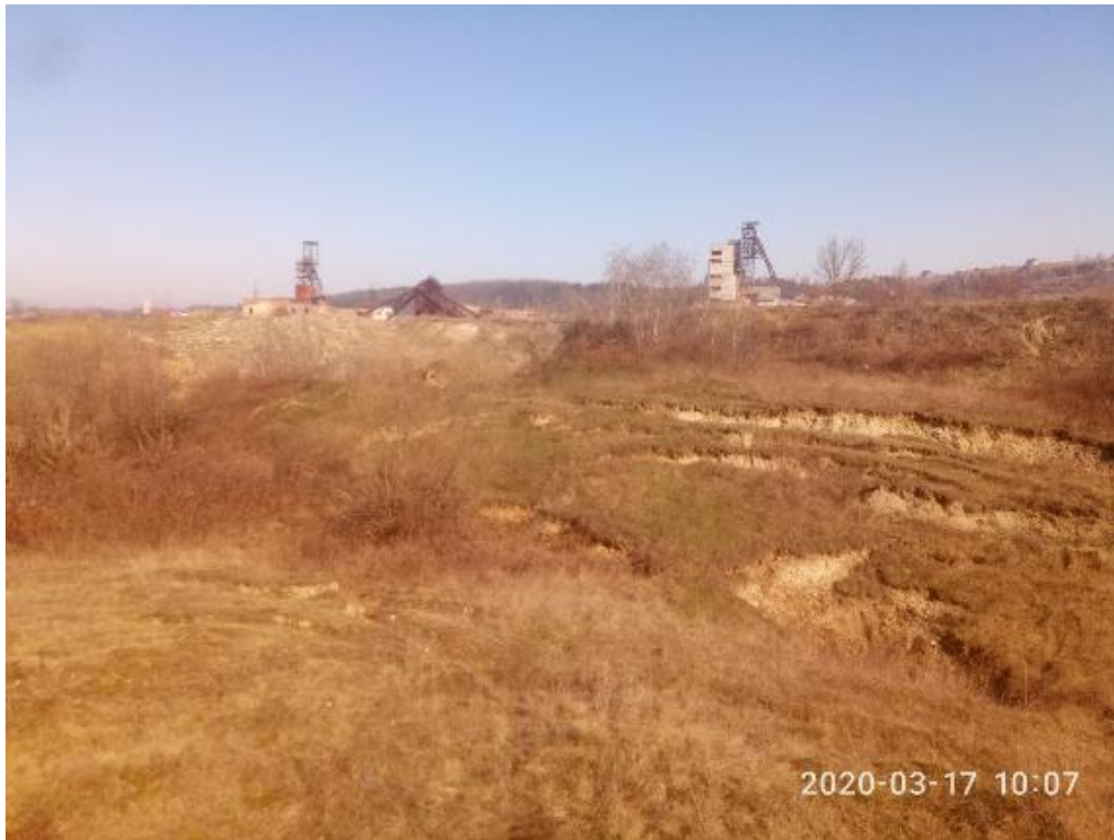
Рис 3 С. Коритоподібна зона осідання, ускладнена карстовими воронками біля південного схилу залізничного насипу (Фото від 17.03.2020)
