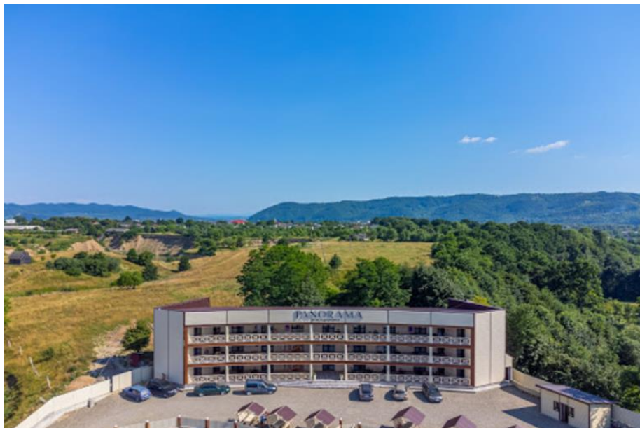
Рис. 3 Г. База відпочинку Панорама (новобудова) з проваллям над гірничими виробками шахти №8 на задньому плані (Фото Олега Науменка, https://hotel-panorama.com.ua/photos/ )
